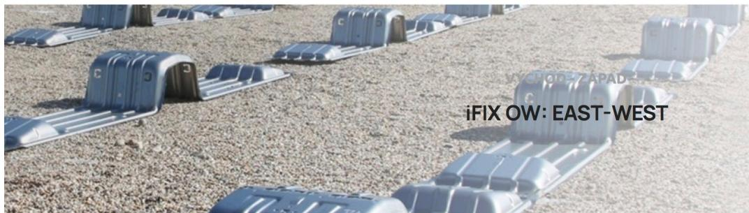
iFix OW je najnovší produkt iFix od spoločnosti Voestalpine. Konštrukciu ju možné použiť plochých strechách, aby ste maximalizovali výnos po celý deň. S konštrukciou iFix **Východ Západ** začnete vyrábať elektrickú energiu hned', ako vyjde slnko, a pokračuje, kým nezapadne.
